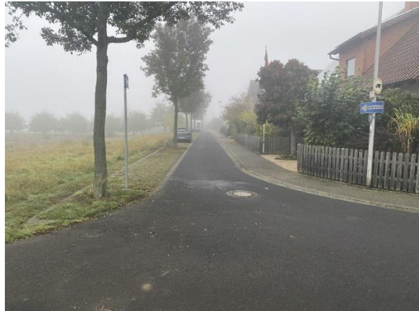
Lessingstraße, Blickrichtung Südwesten
